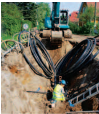
Luigel raskendas kaevetöid vesiliiv.
