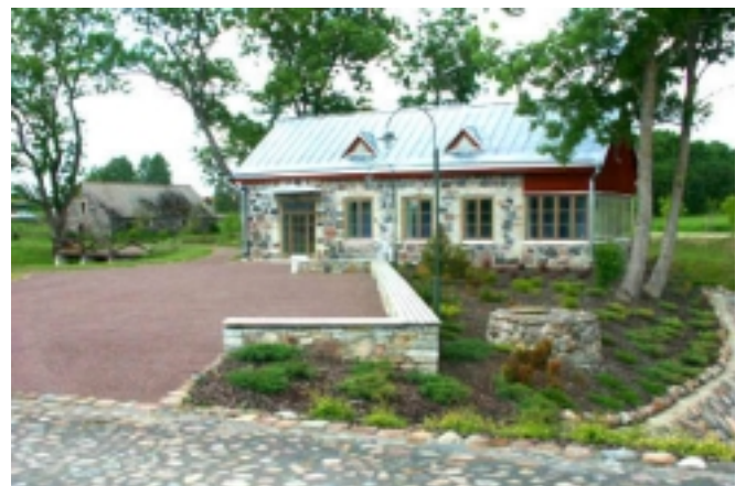
... ja pargipoolne fassaad.
