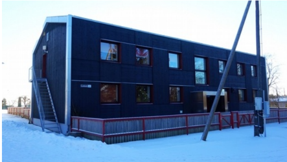
Joonis 2.1.19. Lasteaia tn 26
