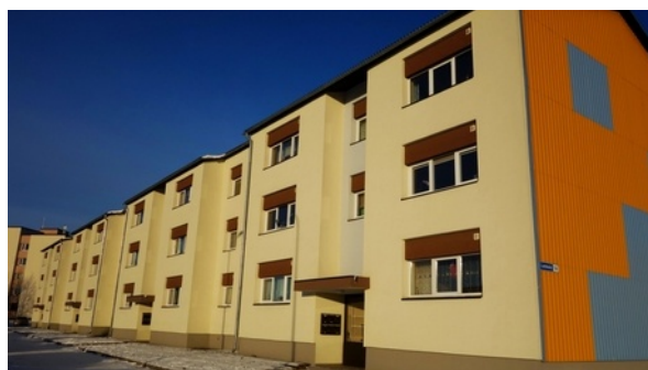
Joonis 2.1.18. Lasteaia tn 14
