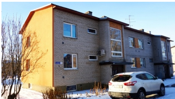
Joonis 5.5.5. Lasteaia tn 11
