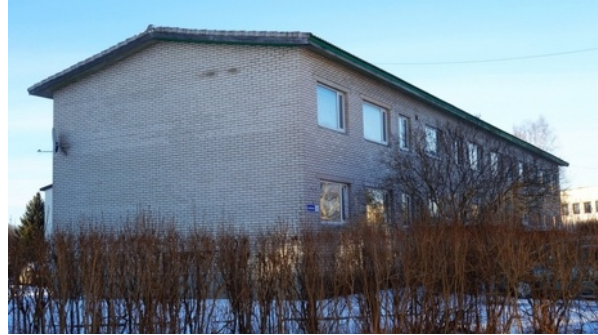
Joonis 2.1.12. Lasteaia tn 5
