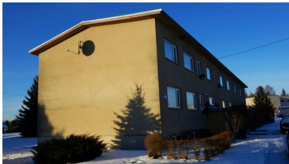
Joonis 5.5.3. Lasteaia tn 1
