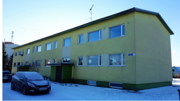
Joonis 2.1.8. Lasteaia tn 2
