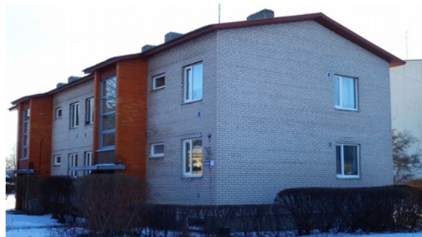
Joonis 2.1.14. Lasteaia tn 7
