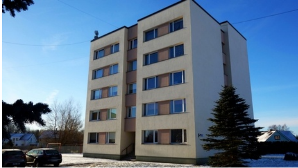
Joonis 2.1.11. Lasteaia tn 4
