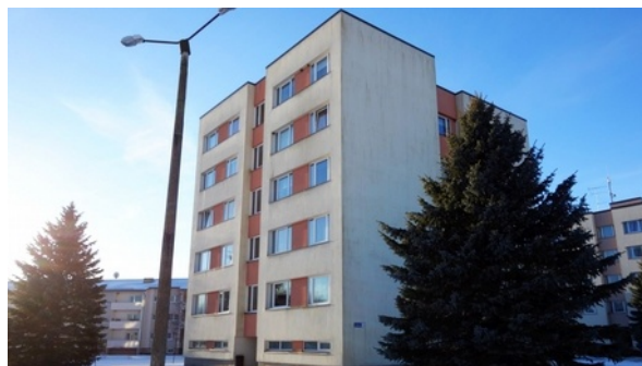
Joonis 2.1.16. Lasteaia tn 10
