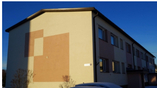
Joonis 2.1.10. Lasteaia tn 3
