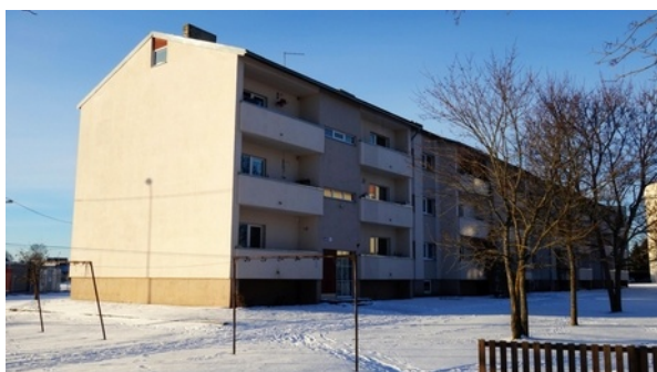
Joonis 2.1.17. Lasteaia tn 12
