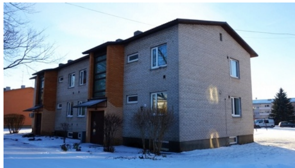
Joonis 5.5.4. Lasteaia tn 9
