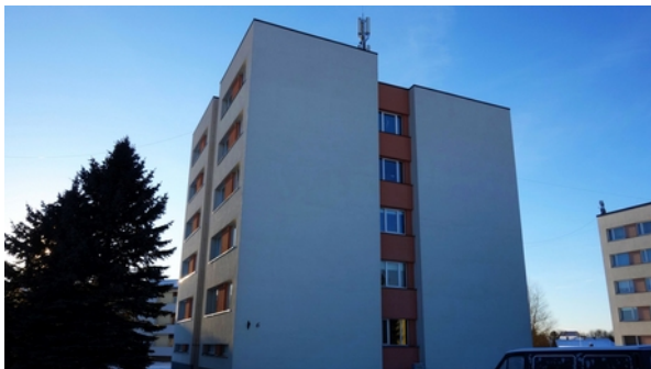
Joonis 2.1.13. Lasteaia tn 6
