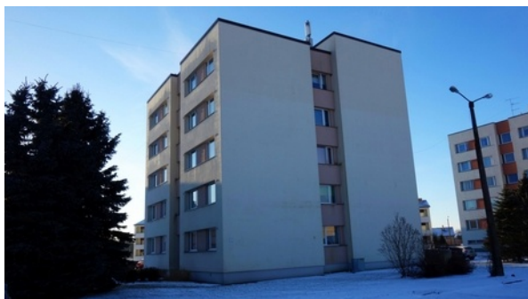
Joonis 2.1.15. Lasteaia tn 8
