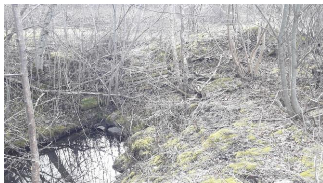
Pilt 4 – 20230415 Sahkari kraavi truup Lootuse tn 17 üldmaal. Truubi settinud sissevool on veepinna üles paisutanud.
