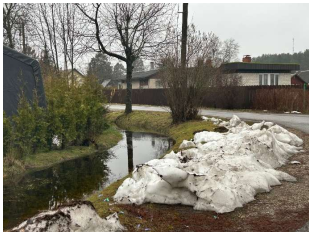
Joonis 6.8. 2025. aasta jaanuaris esinenud liigvee äravoolu probleem Kuu tänavast kuni Haldja tänavani, kus olemasolevad teeäärsed kraavid on vett täis, vee äravool suublasse on ebapiisav. Vasakpoolne foto vaatega Kuu tn 26 poolt Marsi tn suunas ning parempoolne foto Kaare tn 3 eest vaatega Kaasiku tänava suunas. Fotod: Kuu tänava elanik.
