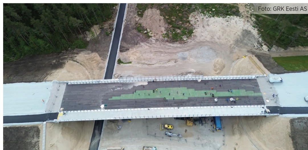
Kangru viadukti hüdroisolatsiooni tööd, juuni 2025.
